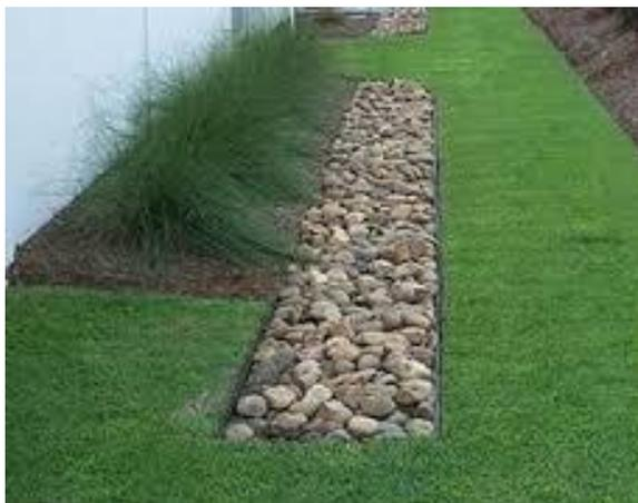
Figura 17 - Exemplo de trincheira de infiltração
